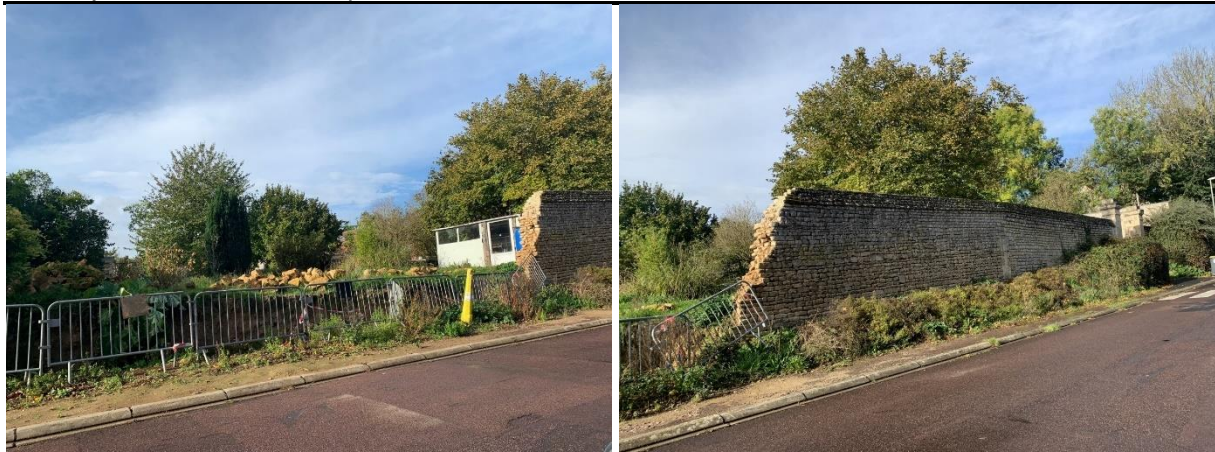
Écroulement d'un mur en pierres sèches, rue Moisson
