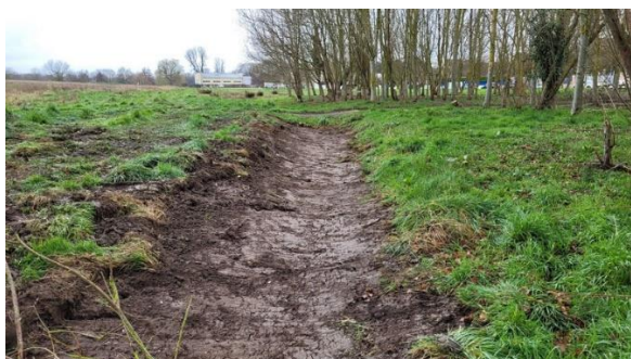
Recreusement des noues
