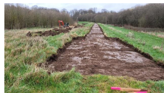
Terrassement du cheminement sur la digue
